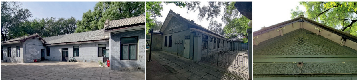
北院16号现状。左起：东面、北侧及西侧、北侧山花（2022年10月5日摄）
