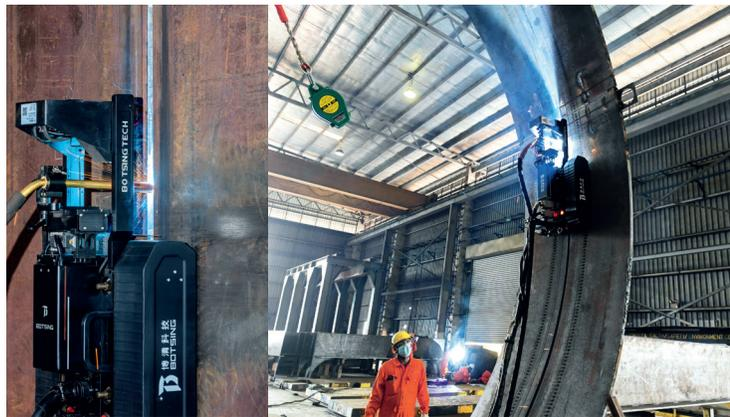
无轨道全位置爬行焊接机器人应用于深海吸力桩焊接项目
