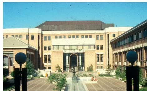
1991建成的清华大学图书馆三期工程。大玻璃顶设计被改大为小、分散组合。分散式小玻璃顶群藏在了现在的平屋顶造型里。
