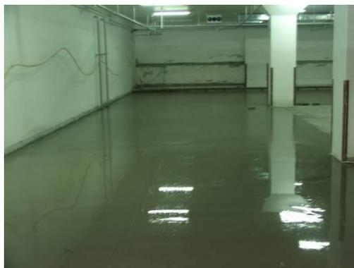
图6 自流平水泥砂浆地面浇筑
