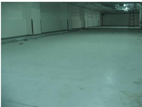
图 7 自流平水泥砂浆地面的养护
