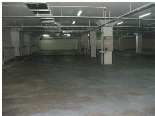
图3 处理好的混凝土基层
