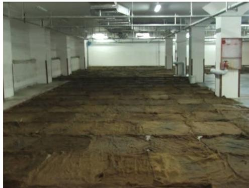
图 8 硬化后自流平地面的表现状态
