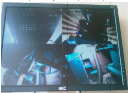
废电路板处理设备监控系统
