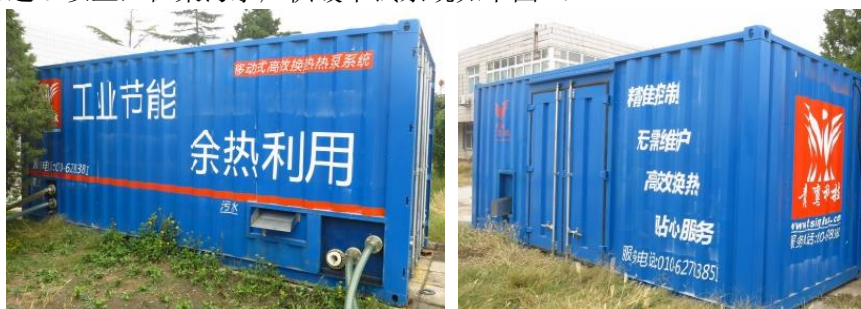
图 2 污水余热利用高效热回收热泵供暖中试系统
