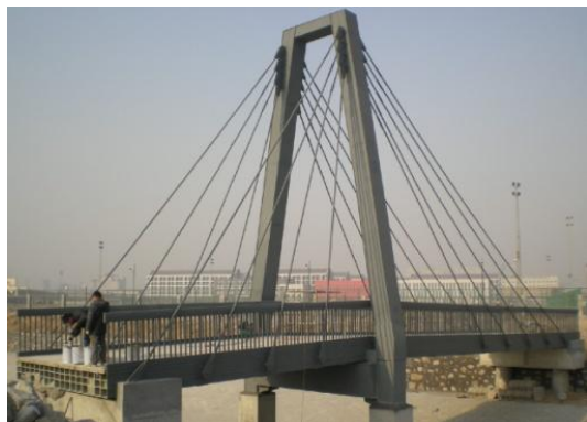
上图：石家庄 1 号 FRP 桥
