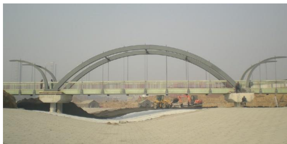
上图：石家庄 2 号 FRP 桥
