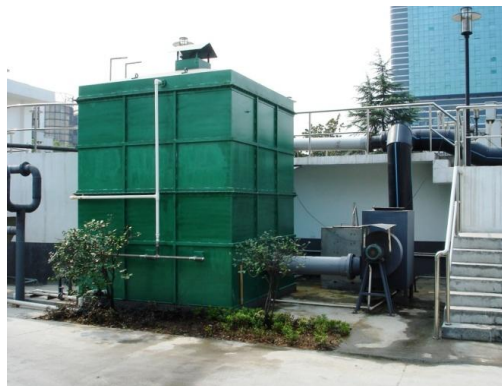
图 1 生物过滤除臭工程
